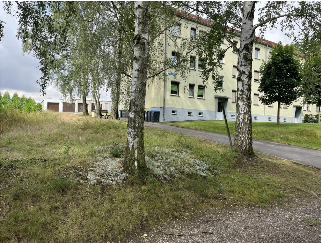
Abbildung 3 – FS 85/3 mit Blick auf benachbartes Wohngebäude und Zufahrt
