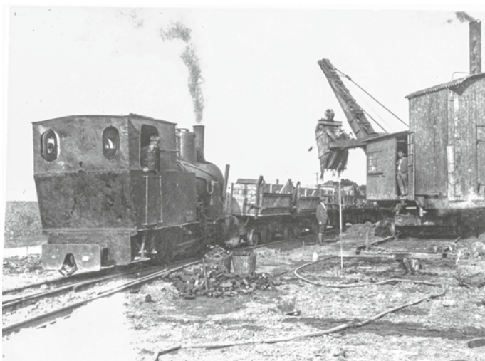
„Dampfidiyll“ beim Bau der Umgehungsstraße und der Kohlebahn. Briketts und Schlauch für Kesselspeisewasser liegen zum „Nachtanken“ bereit. (Foto: Bergbaumuseum Deuben)
