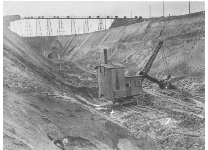
Ausbaggern der Kohleausfahrt Tagebau Wähltitz mit Brücke der Kettenbahn über desn oberen Tunnel (Foto: Bergbaumuseum Deuben)
