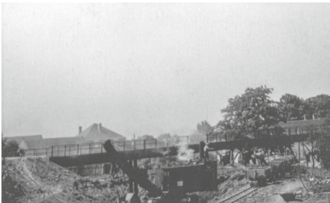
Straßenbau zw. Salzstraße und Kohlebahnbrücke Zetzsch (Foto: Kurt Reichhardt)
