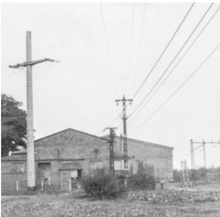
Umformerstation Tagebau Wähilitz I: links 15 kV Freileitung, mitte 1,2 kV Fahrleitung, daneben 5 kV Freileitung KW Wähilitz
