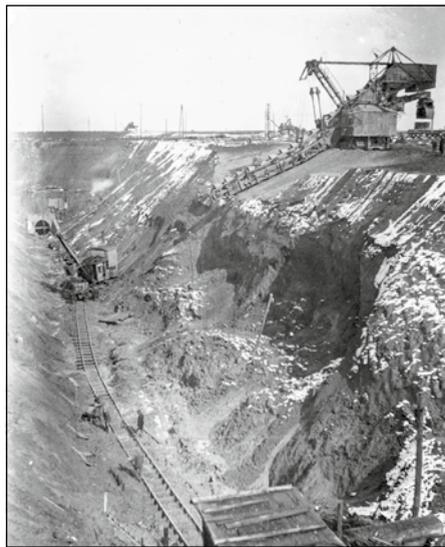
Ausbaggern der Kohleausfahrt. Hinter dem Löffelbagger der „untere Tunnel“
