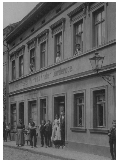
Straßenlaterne in der Mittelstraße
