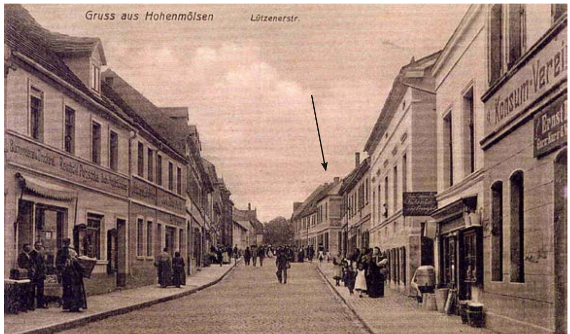
Die heutige Friedensstraße, von ca. 1855-1865 bebaut, wurde zur Hauptgeschäftsstraße Hohenmölsens. (siehe Pfeil: Post von 1882 bis 1892)
