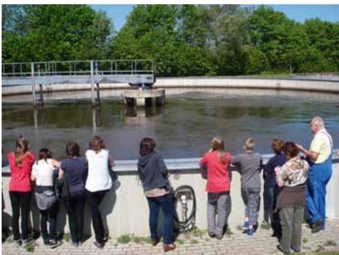
Im nächsten Schritt erfolgt die biologische Reinigung des Schmutzwassers im Belebungsbecken durch Bakterien. Diese entfernen, wie auch bei der natürlichen Selbstreinigung von Gewässern, biologische Verunreinigungen im Abwasser. Durch ständige Zufuhr von Sauerstoff werden hier die Bakterien am Leben erhalten. Stoffe wie Ammonium und Phosphat werden abgebaut, Kohlenstoffverbindungen in Kohlendioxid umgewandelt.
