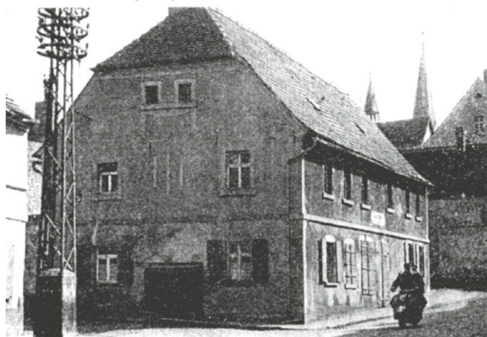
Einspeisemast von 1912 (heutige Ecke August-Bebel-Straße/Badergasse)
