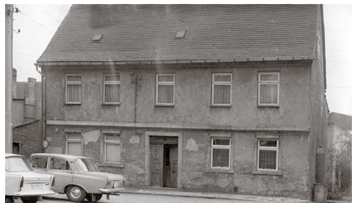
Haus Altmarkt 3 vor dem Abriss
